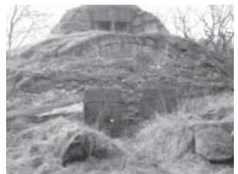
Syftstation med påbyggd kommando-plats på Jutudden, Aspö
